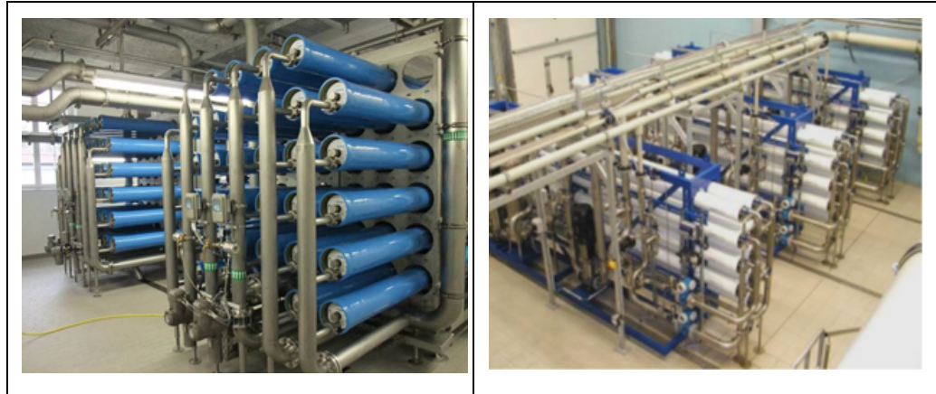
Figur 3.9 Billede af LPRO membraner til blødgøring.
