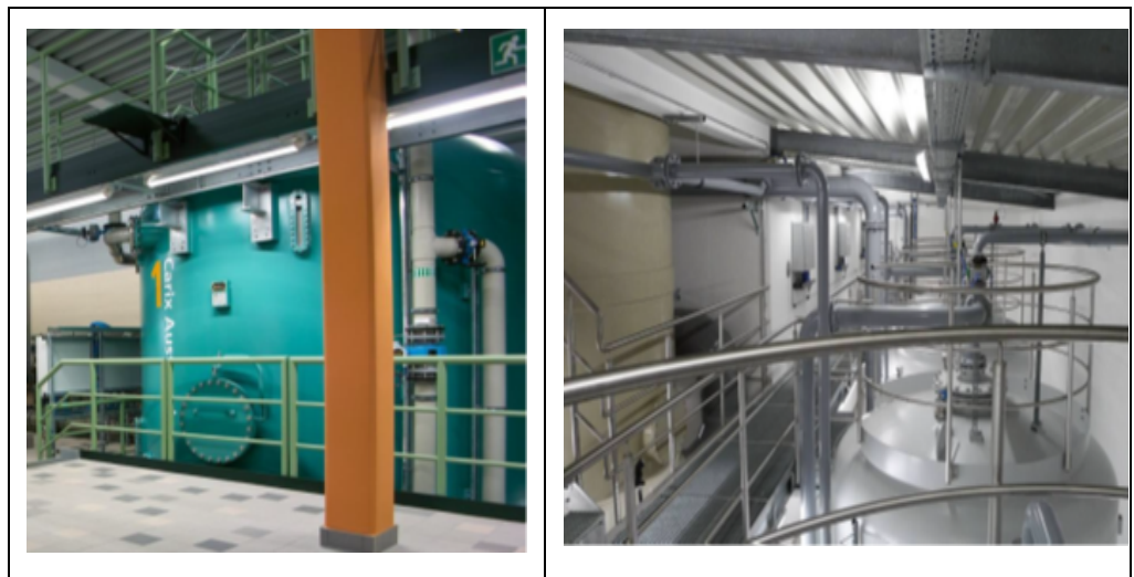
Figur 3.7 Billede af CARIX ionbytter anlæg
