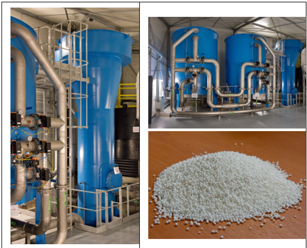
Figur 3.3 Billede af Veolia's Actina kalkpille kolonne og tilhørende filtre samt producerede kalkpiller.
